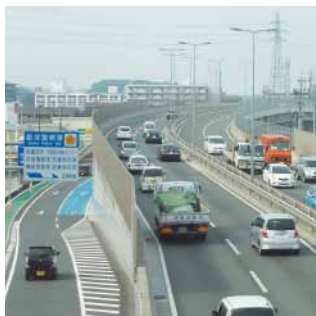
橋や道路の整備
