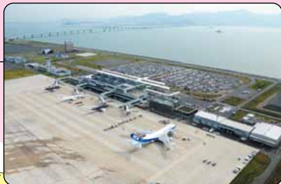
北九州空港（北九州市・苅田町） 工事費約1,024億円
