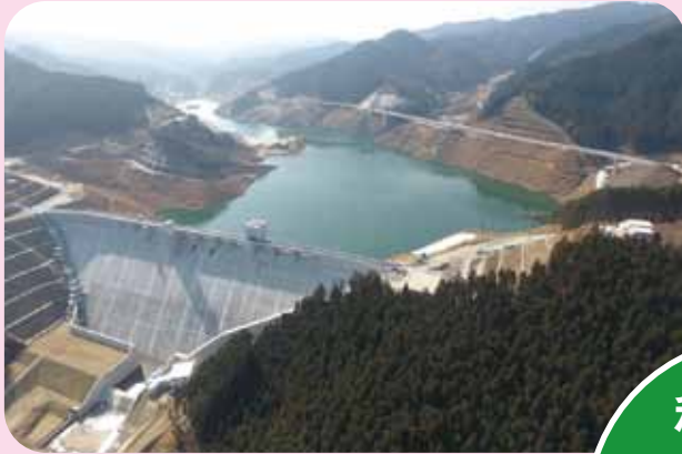
伊良原ダム（みやこ町）
