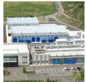
水素エネルギー製品 研究試験センター
