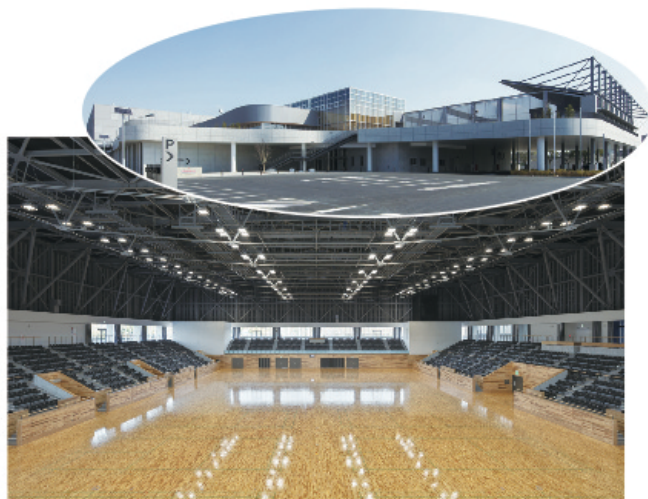
スポーツ施設の整備(久留米アリーナ 工事費約 86 億円) バスケットボールコート 3 面分のメインアリーナ、武道場、弓道場等を備える複合体育施設(平成 30 年 6 月開館)
