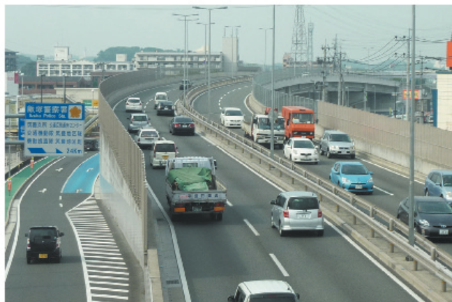
橋や道路の整備(飯塚市片島の立体的な交差点 工事費約 86 億円) 平成 22 年 8 月に開通した一般国道 200 号の片島高架橋
