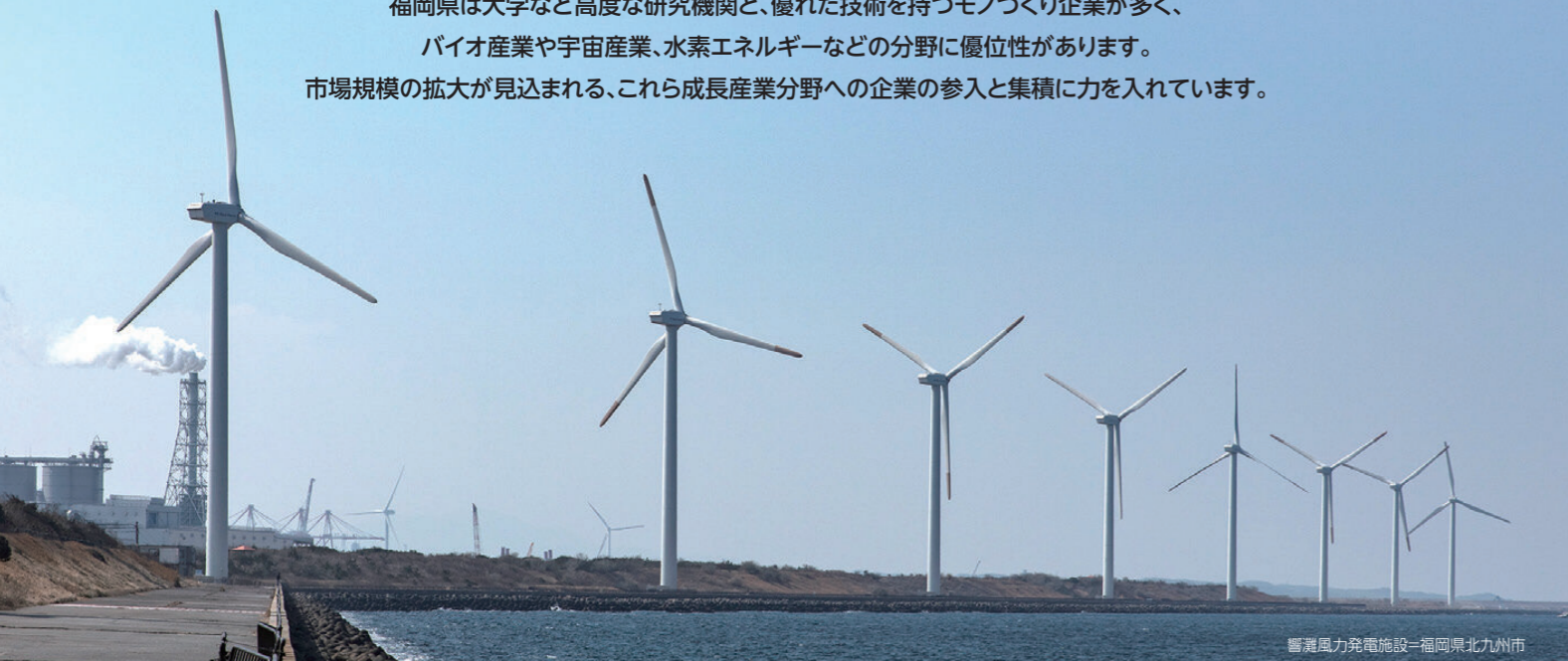
響灘風力発電施設-福岡県北九州市
