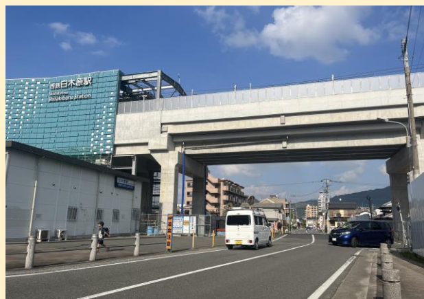
西鉄天神大牟田線連続立体交差事業
