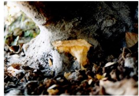
(樹皮を剥ぐと、台木との境に亀裂が確認できる)
