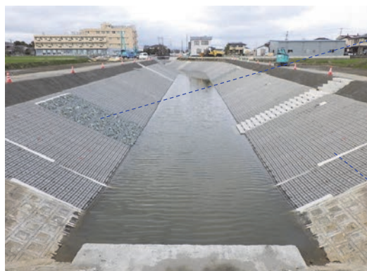
施工後（生物の代替環境の創出に配慮した護岸）
