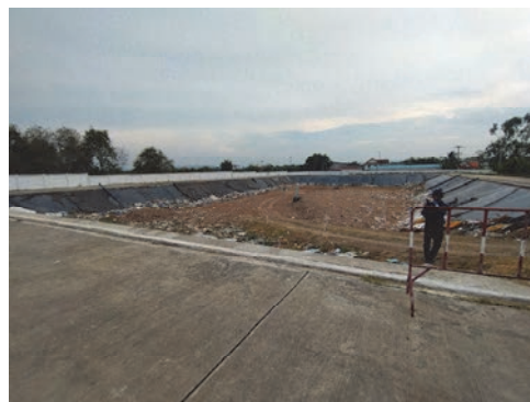
タイ・シーキウ市処分場の埋立状況
