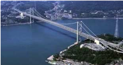
○関門橋の通行止め状況 (H22~H26)
