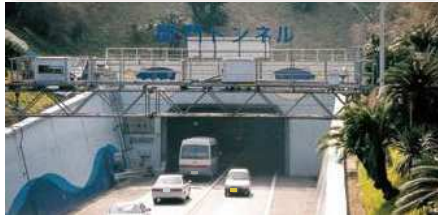
○関門トンネルのリフレッシュ工事による全面通行止めの状況
