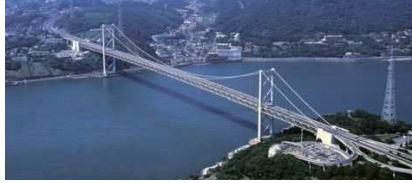
○関門橋の通行止め状況 (H27～R1年度)
