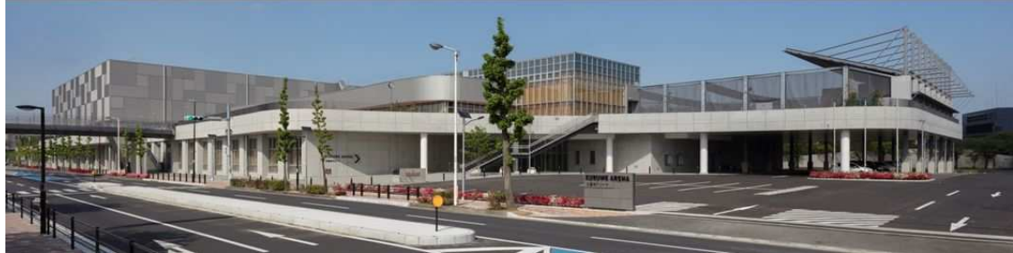
(上：北西側外観 下：南西側外観)
