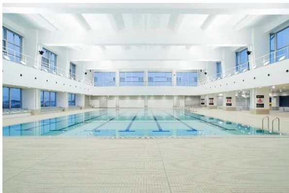
(屋内温水プール室)
