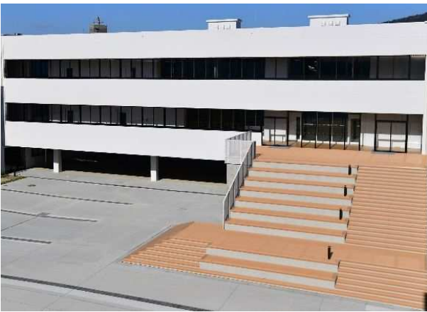
(南側外観：メディア棟)
