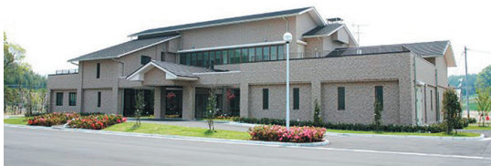
福岡浄化センター（福岡市）
