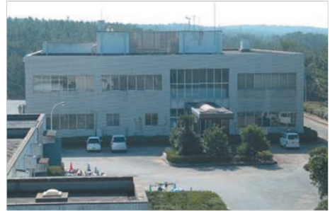
芦屋町浄化センター（芦屋町）
