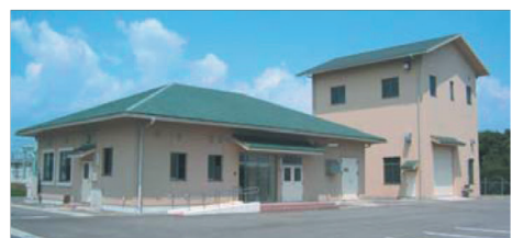
築城浄化センター（築上町）
