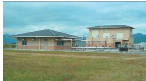
三輪中央浄化センター（筑前町）
