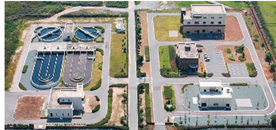
柳川浄化センター（柳川市）
