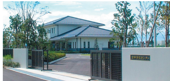
吉井浄化センター（うきは市）
