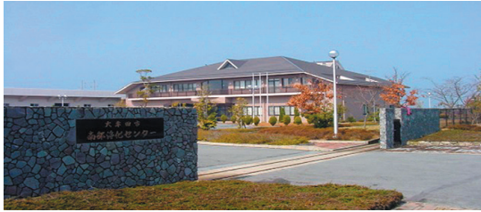
南部浄化センター（大牟田市）
