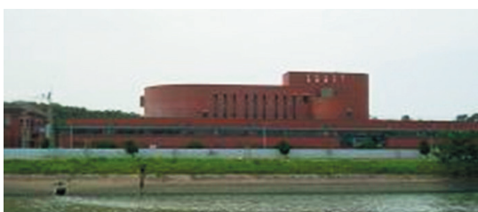
古賀水再生センター（古賀市）
