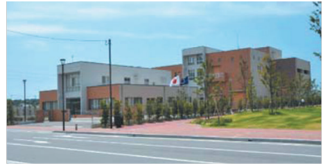
新宮中央浄化センター（新宮町）
