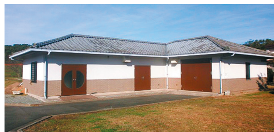
上長田浄化センター（みやま市）
