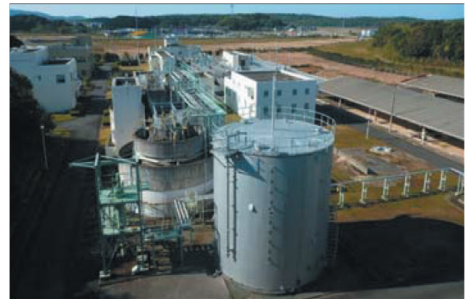
岡垣町浄化センター（岡垣町）
