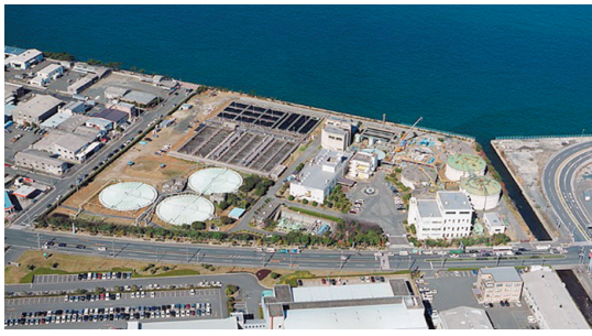
新町浄化センター（北九州市）
