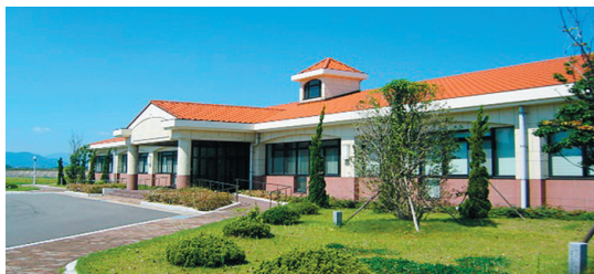
行橋浄化センター（行橋市）
