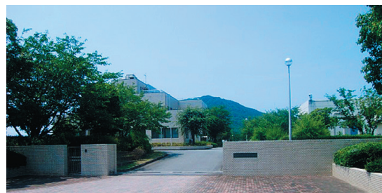
前原下水管理センター（糸島市）
