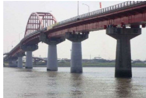
(主) 大牟田川副線 新田大橋工区(大川市)
