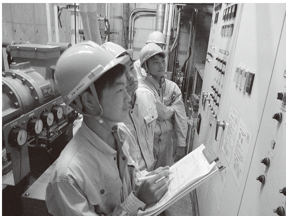
制御盤計器の確認作業
