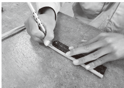
VVFケーブルの剥ぎ取り寸法出し
