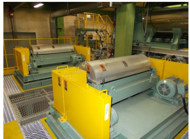
増強工事により更新した機器 （汚泥脱水機）
