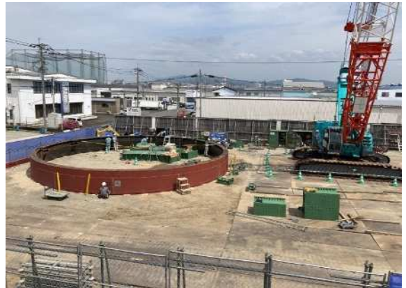
鋼製リング(1リング目)組立
