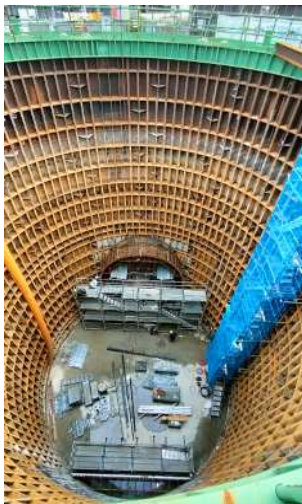
発進立坑内状況
