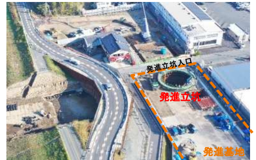
発進基地状況
