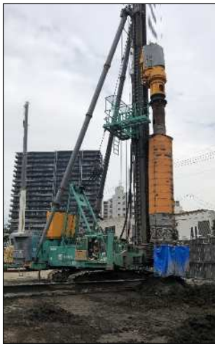
仮設作業状況
