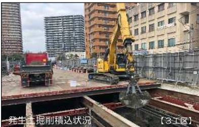
発生土掘削積込状況 【3工区】
