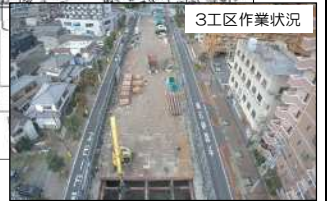
3工区作業状況
