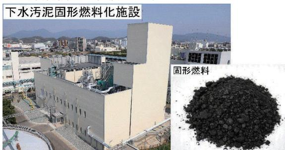
御笠川浄化センターでは、令和5(2023)年度に発生した下水汚泥のうち、77.2%を「下水汚泥固形燃料化施設」、16.7%を「油温減圧式乾燥施設」で処理し、残り6.1%については場外搬出等を行い、次表のとおり再利用を図っています。
