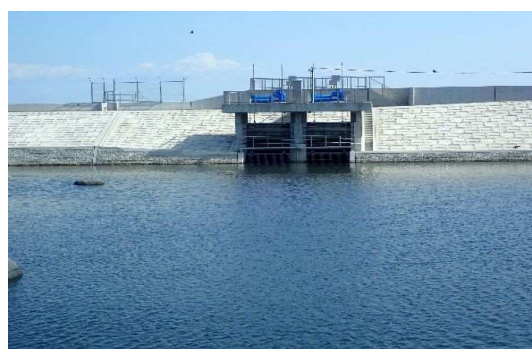
海岸堤防等老朽化対策事業（蓑島地区）
