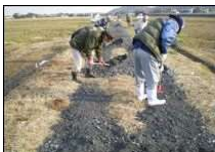
農道の補修作業 （多面的機能支払）
