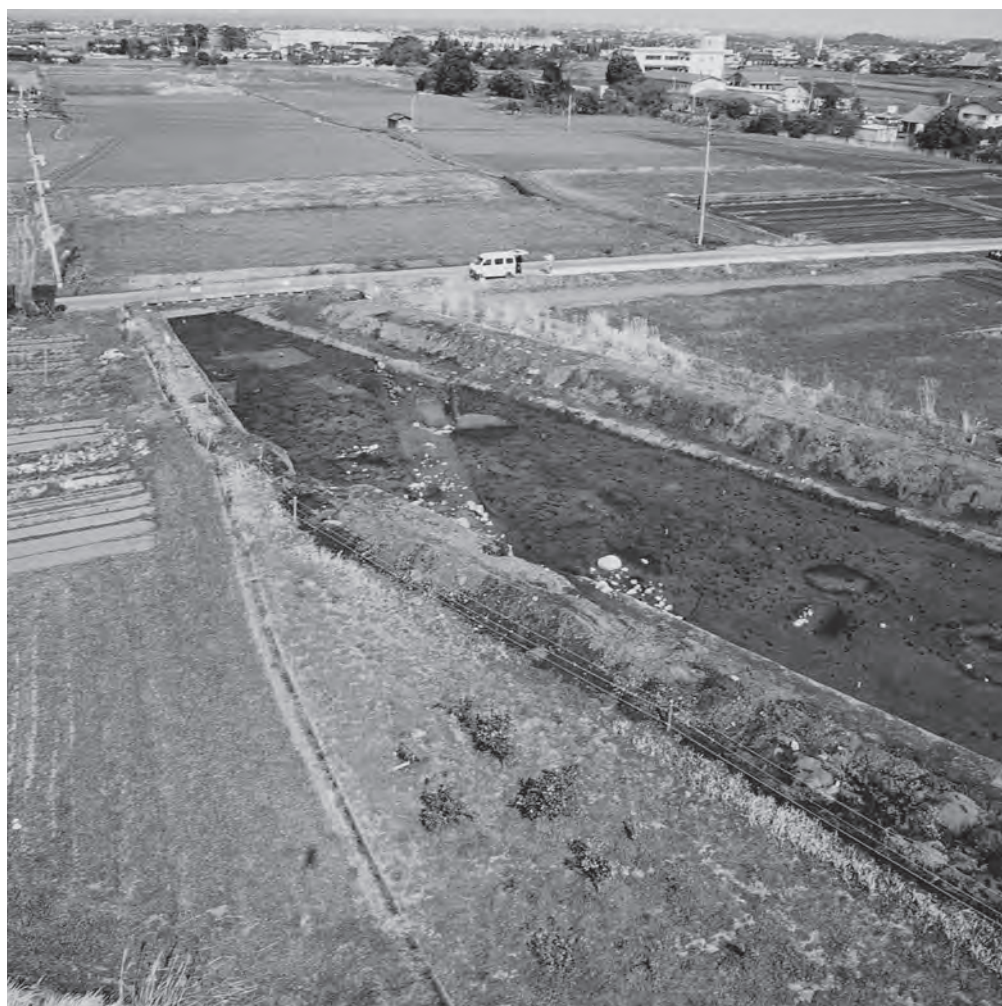
2 調査区北半部（南西から）
