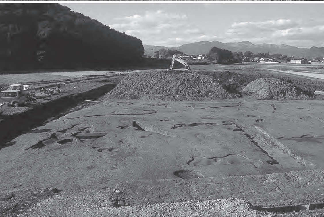
3. 南東部全景 (南東から)
