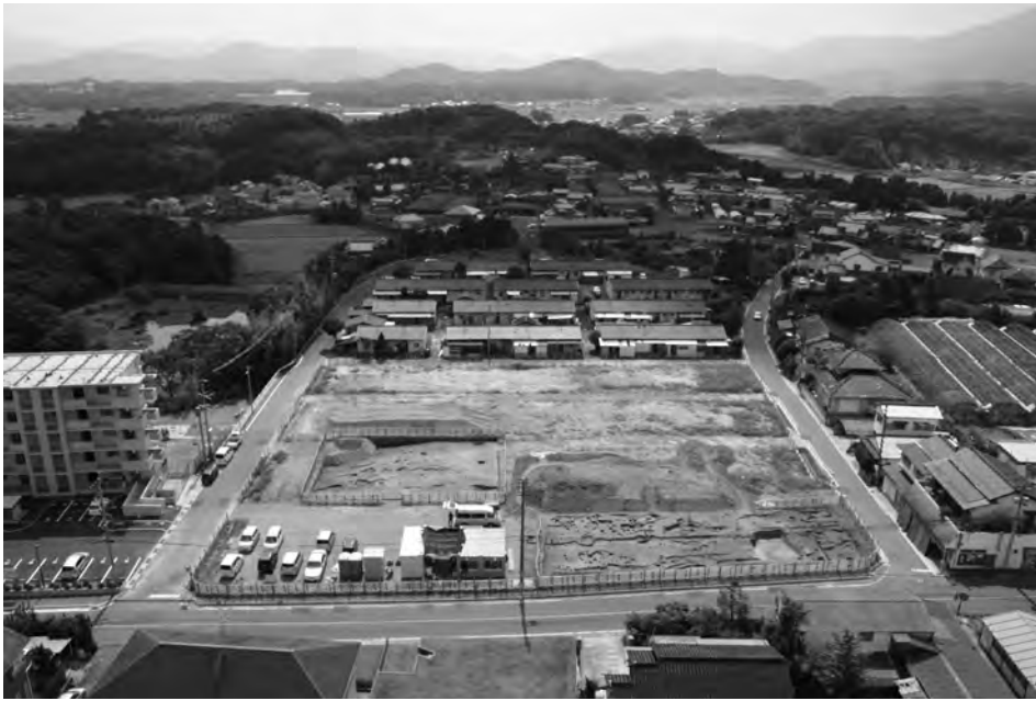
1 調査区近景 (北から)
